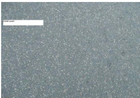
Nr 7: Asfalt Zwart asfalt
