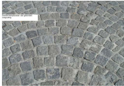
Nr 12+13: Bestrating type 3 Kleinplaveisel in gebonden voegvulling
